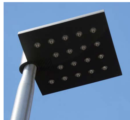
Les nouveaux lampadaires composés de LED pour un gain d'énergie
